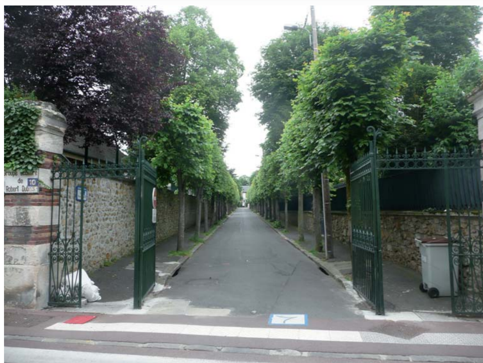
Impasse Robert Dubois : anciens vestiges (murs de clôture + portail + alignement planté) de la propriété Monmartel
