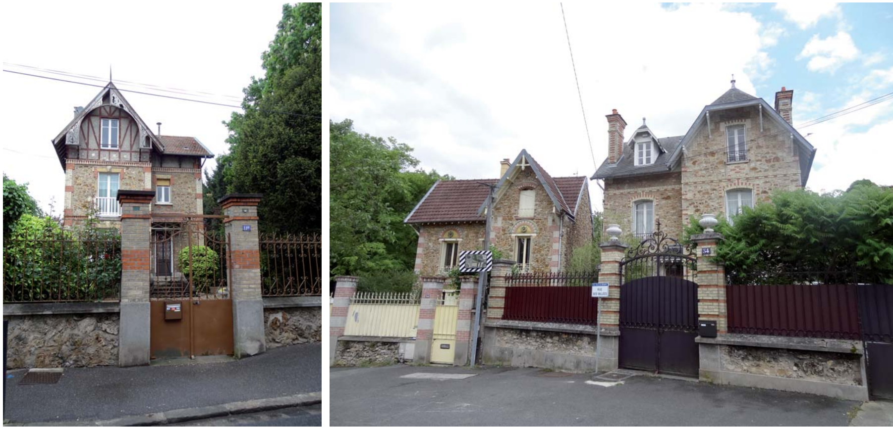
La villa dans ses différents canons : volumes complexes, jeux de toitures, appareils en meulière, décors...
