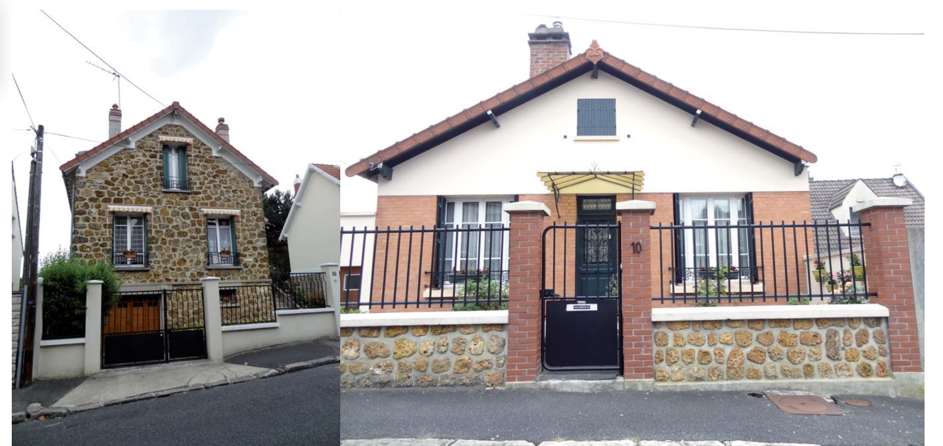
Les matériaux peuvent être divers : meulière, brique, pierre, moellon.
